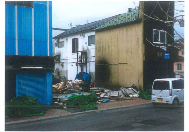
↑ 築60年の建物が解体、さら地に
